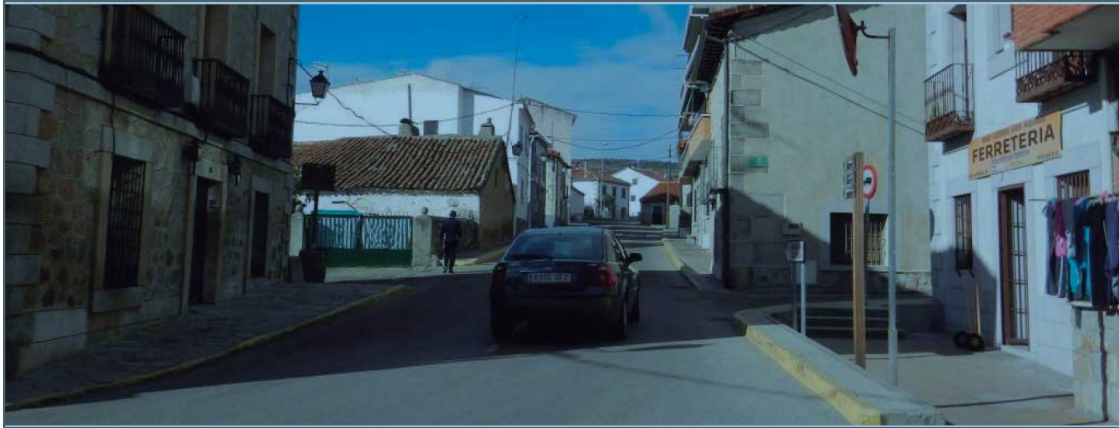
Tramo con aceras de insuficiente dimensión, con obstáculos insalvables y escalones
